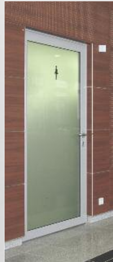
Sichtschutz durch Mattfolie innerhalb des Glases oder auf Scheibenoberfläche aufgesetzt.
